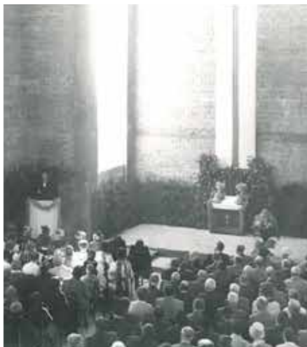
Gottesdienst im Rohbau der Kirche Quelle: Unbekannt
