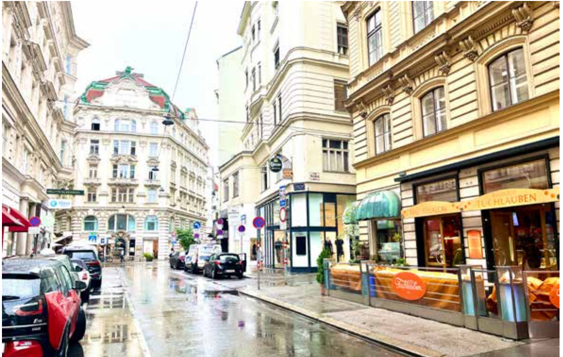
Abbildung 7: Tuchlauben, 1010 Wien. Die Gewandkeller, von denen aus die Tuchballen verkauft wurden, konzentrierten sich auf einen Straßenzug, der heute noch den Namen Tuchlauben trägt. Da Tauber aus den Grundbüchern nicht als Eigentümer eines solchen Gewandkellers hervorgeht, wird er sein Lokal gemietet haben. Bild: Siegfried Kröpfel
